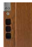
otwór zaczepowy zamka górnego
